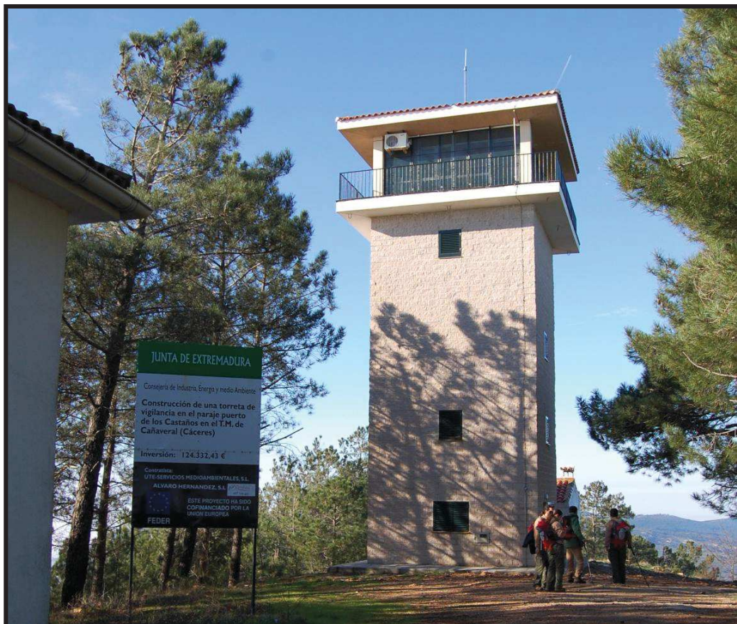
Torre de vigilancia
