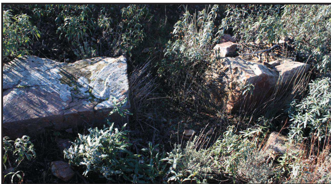
Puerta de la edificación
